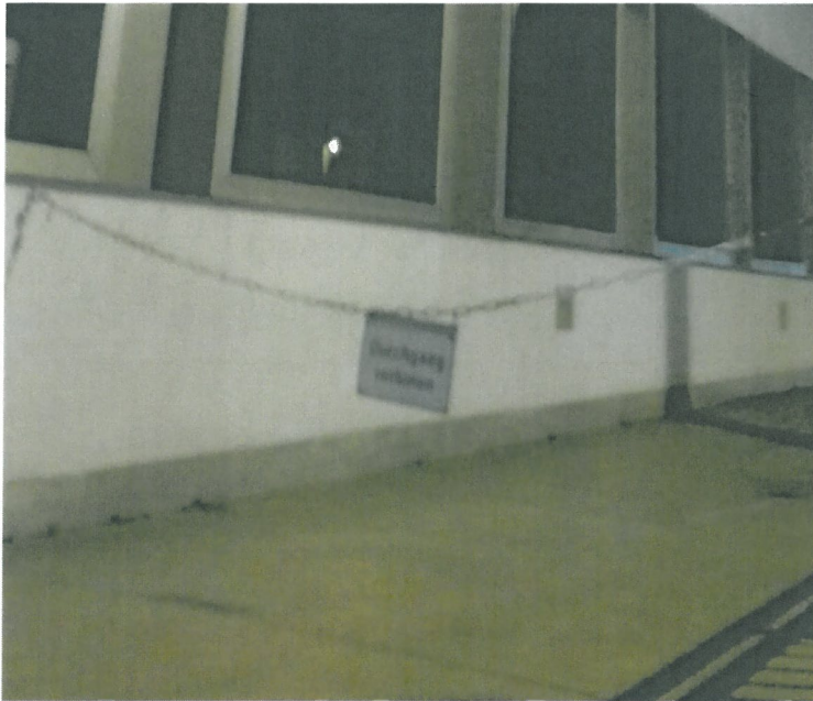
Abb.1.:Derzeit gesperrte Treppenzugang am Schanzl, Passau
